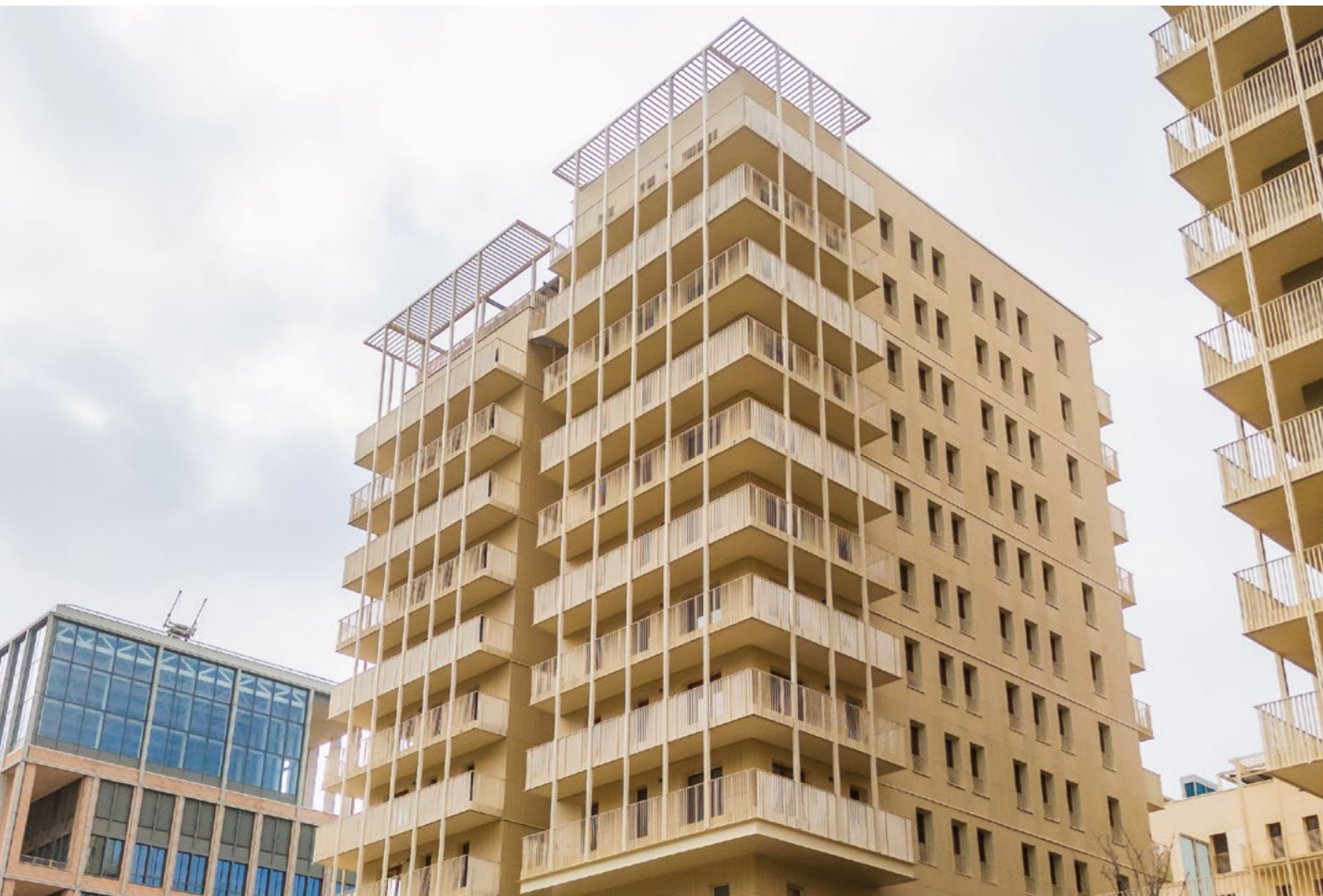
L'immeuble de coliving
